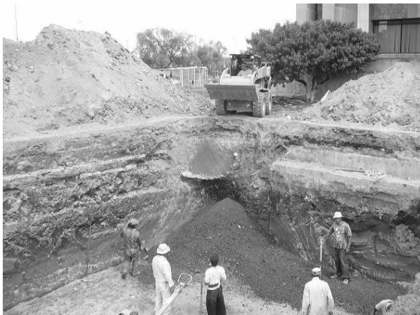
En la presente imagen se observan los trabajos de colocación de relleno aligerado compactado en la zona de la cisterna.
