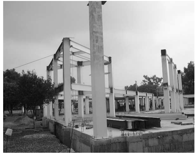
Vista panorámica del edificio del centro de desarrollo infantil, fachadas sur y poniente.
