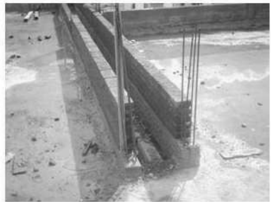
Vista general de la construcción del muro a base de tabique rojo para domo
