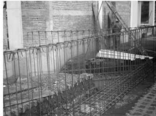
Armado de acero de refuerzo para la construcción de la cimentación y muro de colindancia lado poniente del cuerpo número 1
