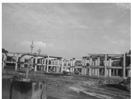
Vista frontal de los trabajos de montaje de estructura metálica del edificio del Cendi
