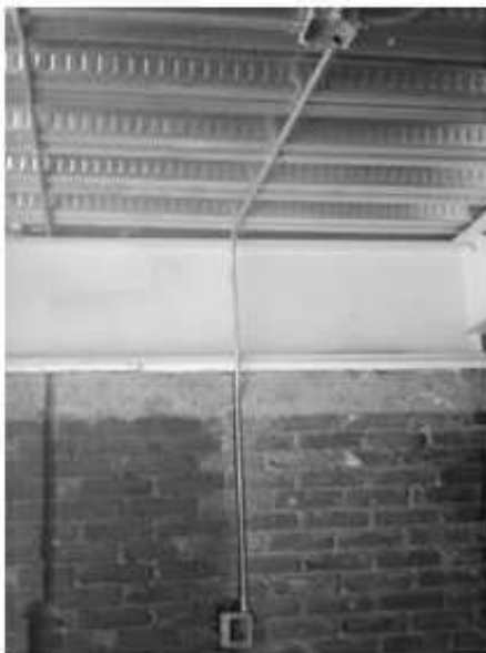
Vista general de la colocación de la instalación eléctrica
