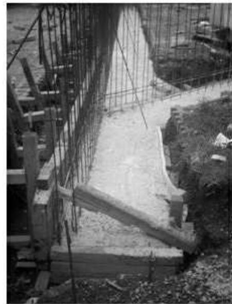
Vista general del colado de la zapata corrida del muro de colindancia lado poniente del cuerpo número 1
