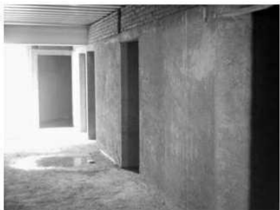
Vista general de los trabajos de repellado que se llevan a cabo en el edificio del Cendi
