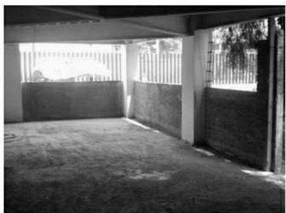
Vista frontal de los trabajos de aplanado y repellido en los muros interiores del edificio del Cendi
