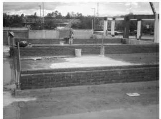
Cosntrucción de muro de tabique rojo para pretil en azotea
