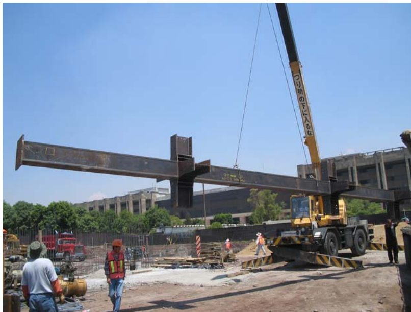
Montaje de estructura metálica
