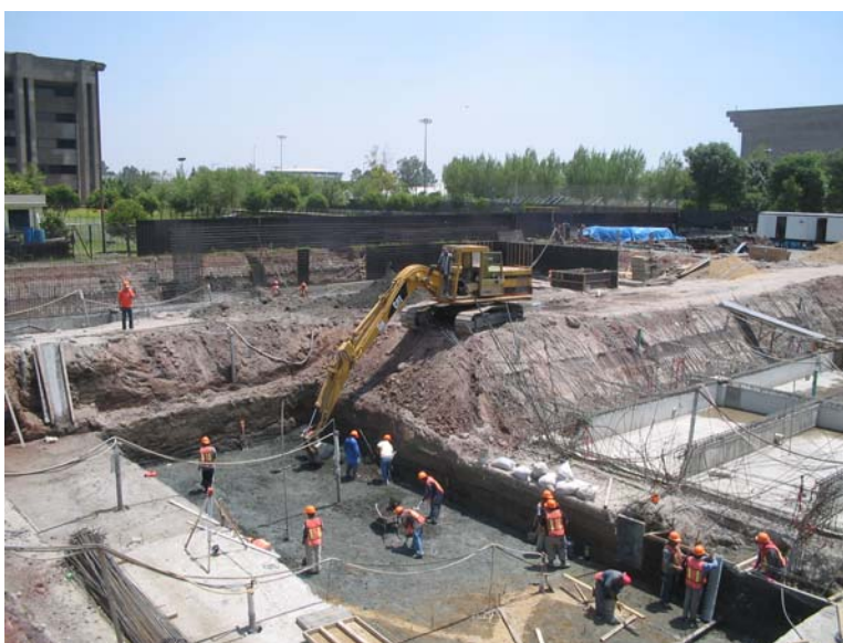
Excavación para la cimentación en área de cisterna
