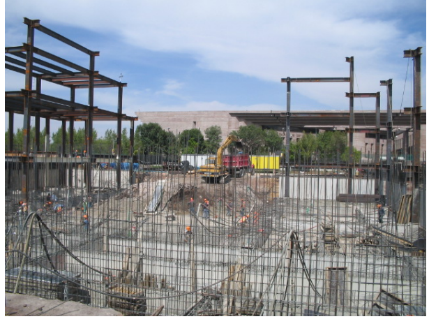
Proceso de montaje de la estructura metálica
