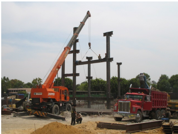
Proceso de montaje de la estructura metálica
