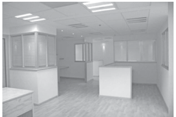
Remodelación de Oficinas
