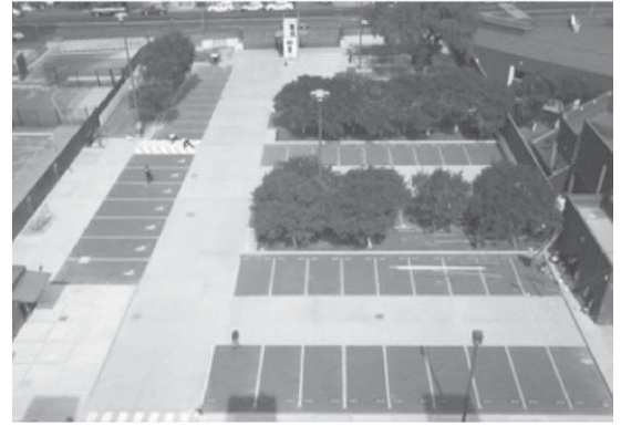
Remodelación del Estacionamiento 2
