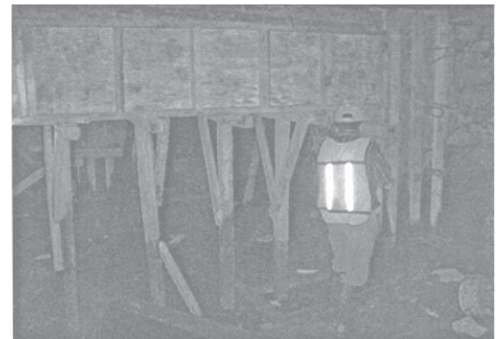
Mantenimiento a Electromecánicos
