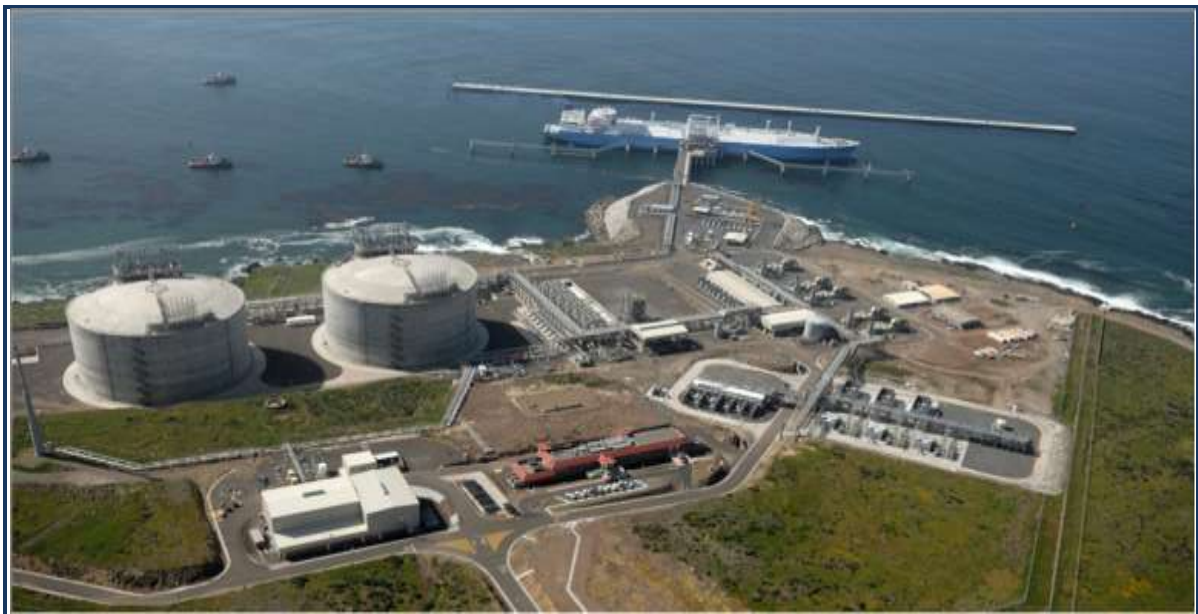
Foto aérea de la Terminal GNL Energía Costa Azul, en Ensenada, Baja California
