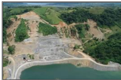
PORTAL DE ENTRADA
