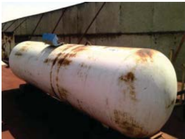
Sustitución de los tanques estacionarios de gas LP
