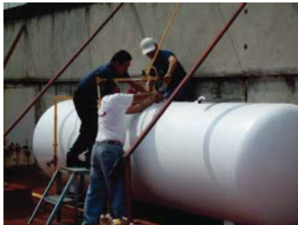
Sustitución de los tanques estacionarios de gas LP
