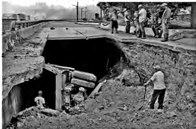
El concreto del hueco del río Huacraje se hundió, en un franco abierto a la catástrofe al paso de un caudal de aguas que transportaba todo de las obras de desahúe en lo que fue el área más afectada de Chahuarang, desde el desahúe en el pueblo de la presa Cerro Negro. ▼ Foto: José Luis de la Cruz
