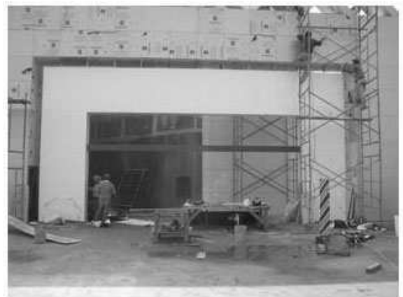
Detalle de la colocación de mármol en fachada norte.
