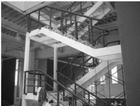
Construcción de escalera metálica.
