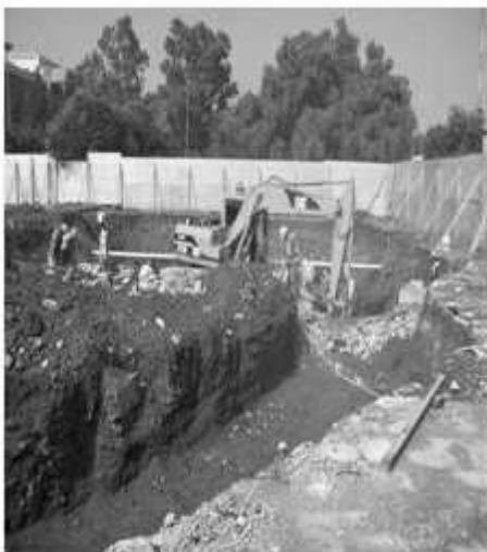
Excavación a máquina para el desplante de la cimentación.
