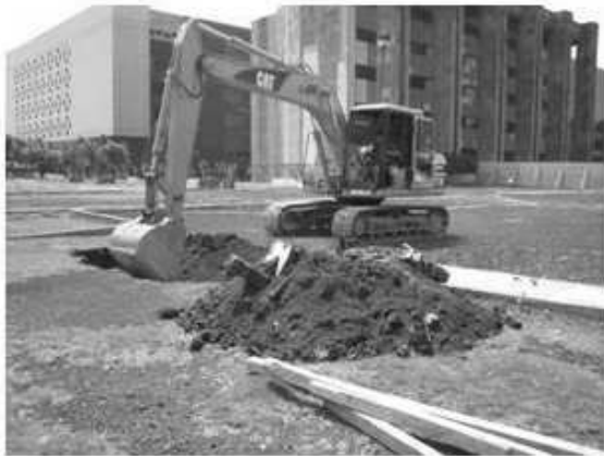
Inicio de excavación.
