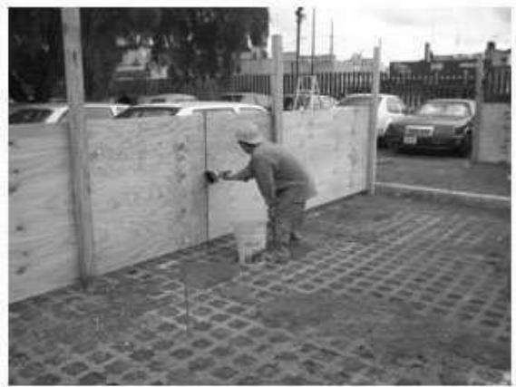
Aplicación de diesel para protección de tapial.
