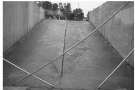
Vista de la rampa de acceso al Sótano.
