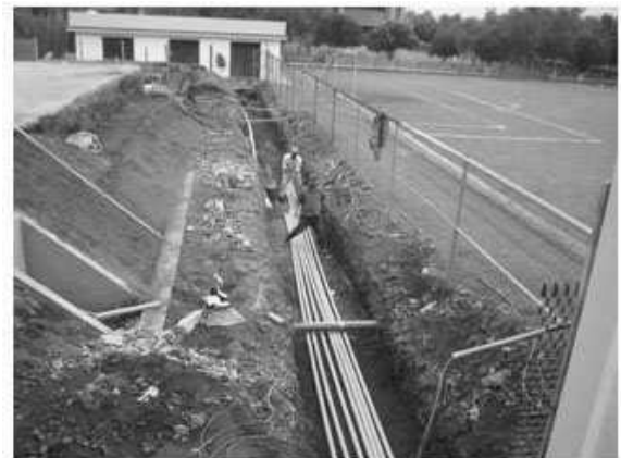
Colocación de tubería de PVC para las líneas de voz y datos.
