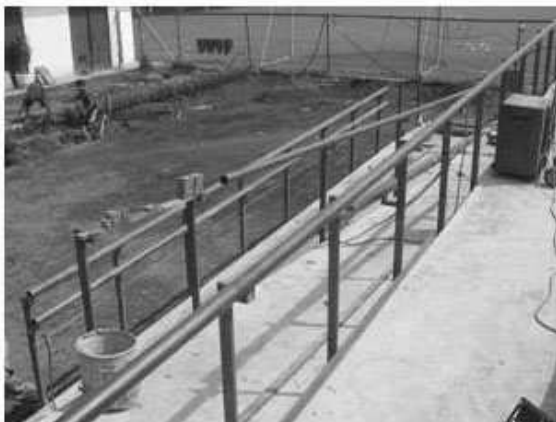
Montaje de estructura metálica en el barandal de rampa de la plaza norte.
