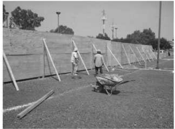
Colocación de tapial de madera para confinar el área de trabajo.
