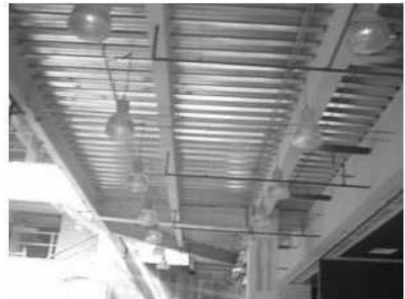
Colocación de lámparas.
