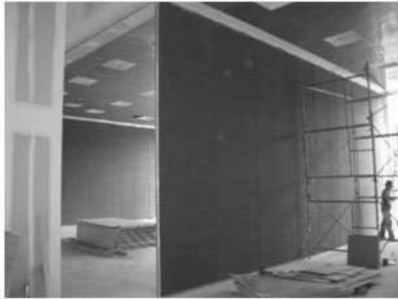
Vista de los muros móviles en la planta baja
