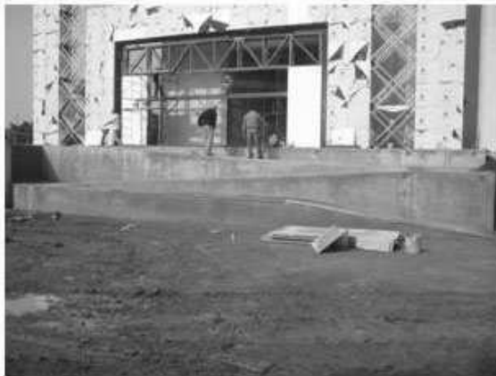
Construcción de la rampa para minusválidos en la plaza oriente.
