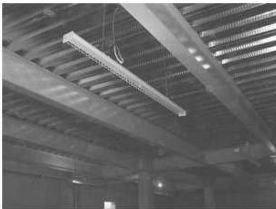
Colocación de lámparas en el sótano.
