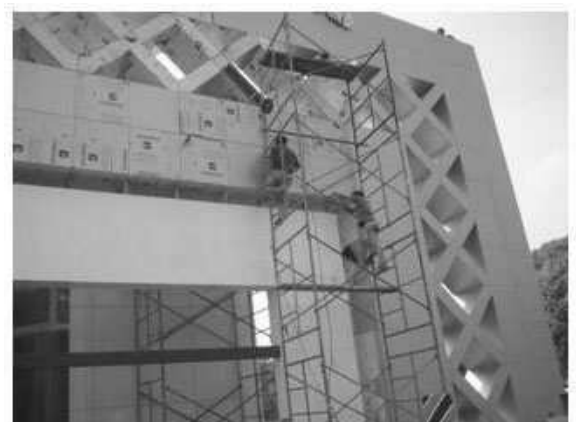
Colocación de panel de aluminio en el marco de acceso norte
