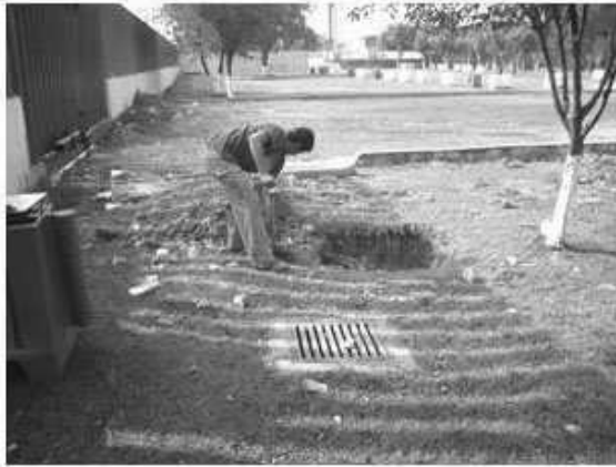
Excavación a mano para ubicar líneas de instalaciones.
