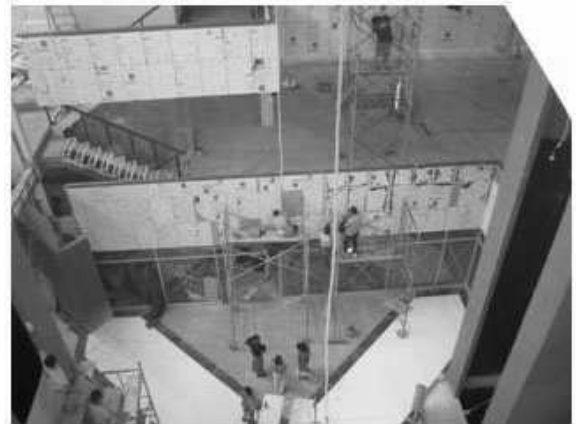
Vista de la colocación de panel de aluminio en la plaza central dentro del edificio.
