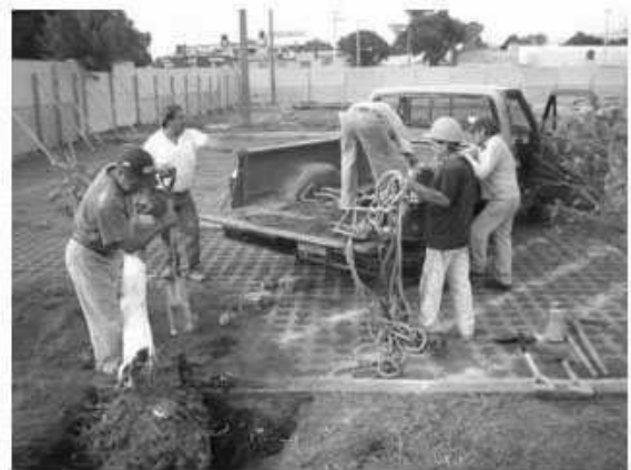
Retiro de árboles existentes en zona de obra.
