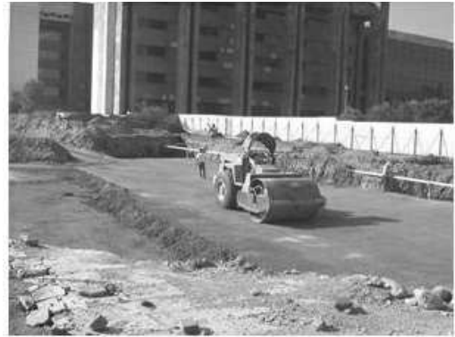
Compactación de la tercera capa de mezcla tezontle-tepetate
