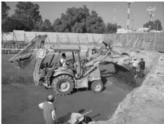
Colocación de mezcla de tezontle-tepetate
