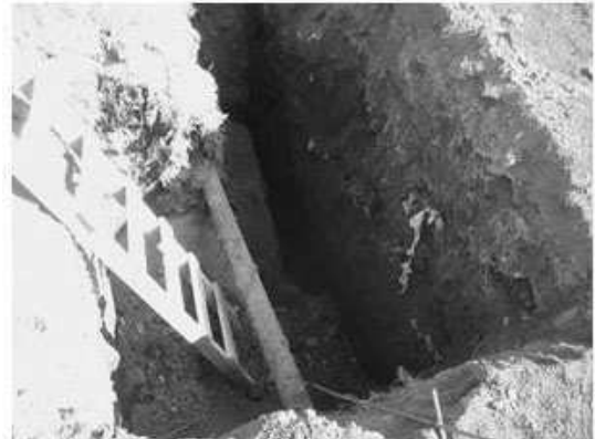
Excavación para ubicar línea de instalaciones existentes en la zona de obra
