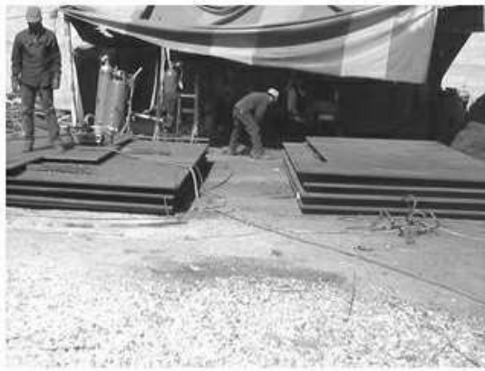
Vista de la placa de acero
