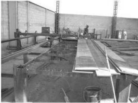
Corte de placa de acero para columnas de tres placas
