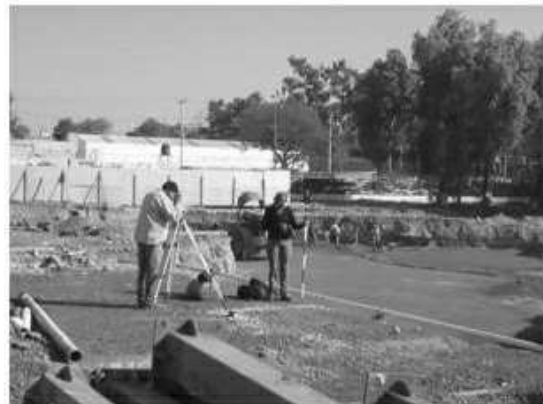
Equipo de topografía realizando nivelación del área de trabajo
