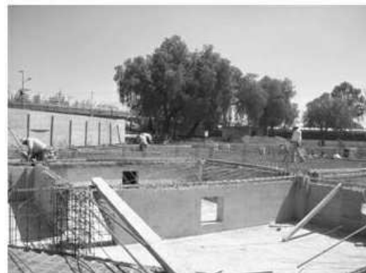
Retiro de cimbra en la cimentación.
