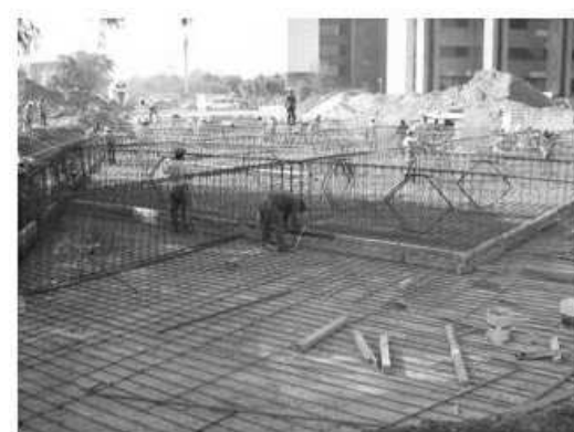
Armado de acero de refuerzo para construcción de cimentación.
