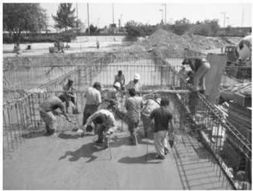
Detalle de la colocación de concreto en losa de cimentación.
