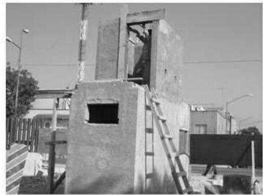
Aplanado de muros exteriores en la caseta de vigilancia (acceso norte).
