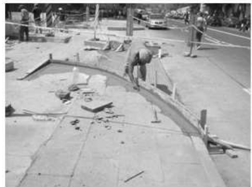
Trabajos de albañilería en el acceso al estacionamiento.
