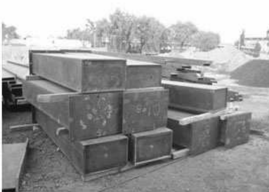
Estructura metálica, columnas suministradas en la obra.
