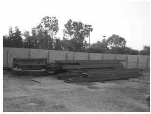
Vista de traves metálicas suministradas en la obra.
