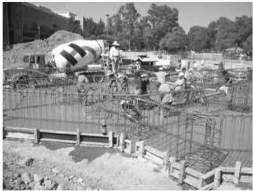
Colocación de concreto para construcción de losa de fondo de cimentación.
