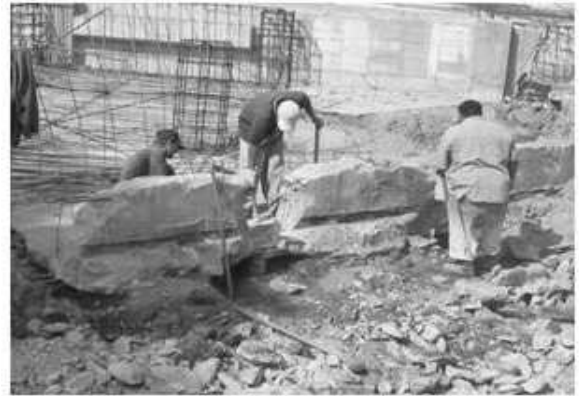
Demolición de elementos estructurales existentes dentro de la excavación
