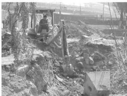
Vista de la excavación complementaria con equipo
