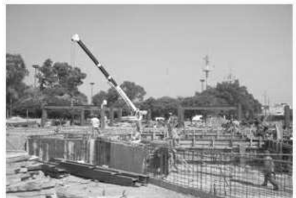
Colocación de cimbra en contratraveses de la cimentación
